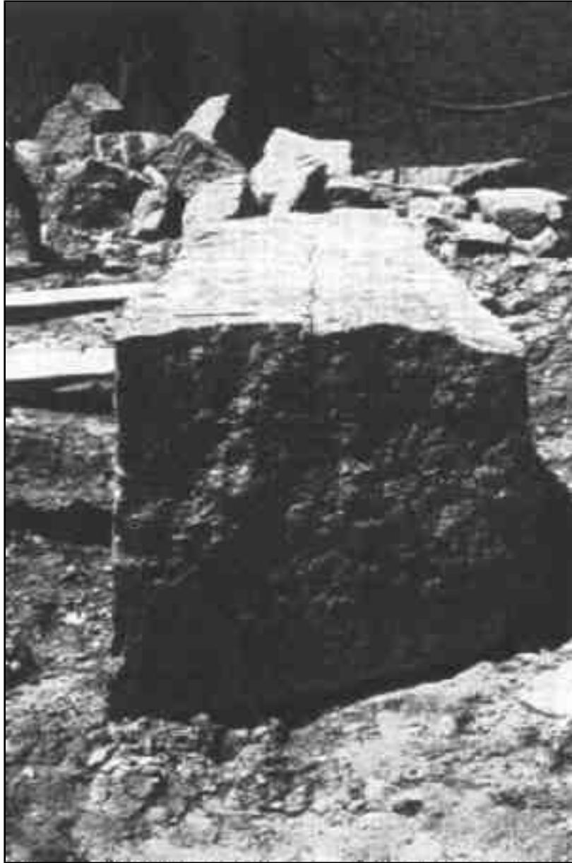
Abb. 3: Deutlich erkennt man, wie der Granit auf der Linie bricht, wo die Keile hineingetrieben wurden.
