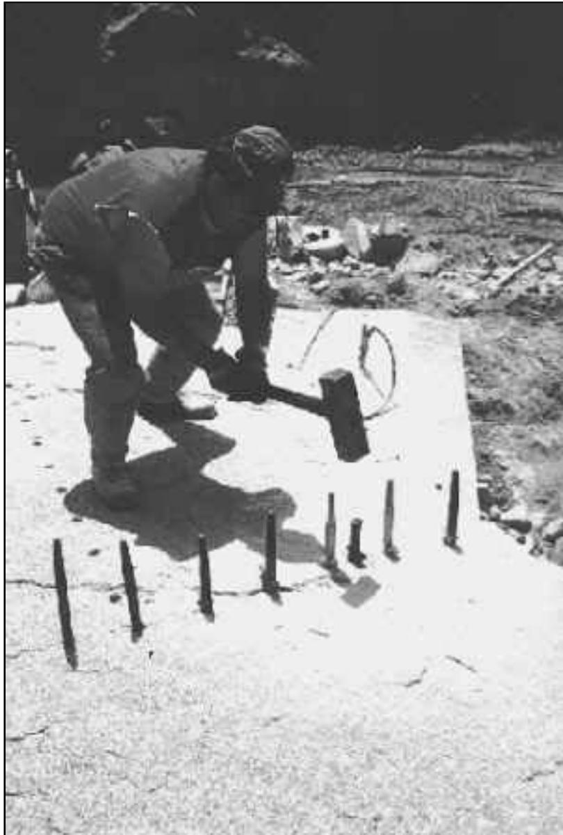
Abb. 5: Beim Einschlagen der Keile (Foto: Löhner)
